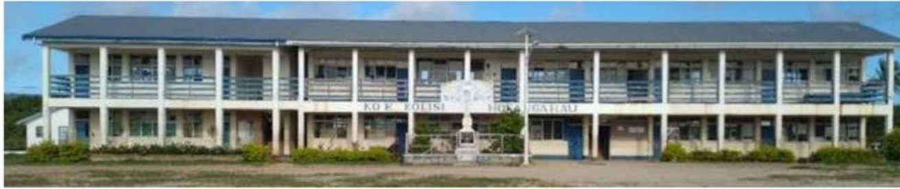
Inspección de inmuebles
