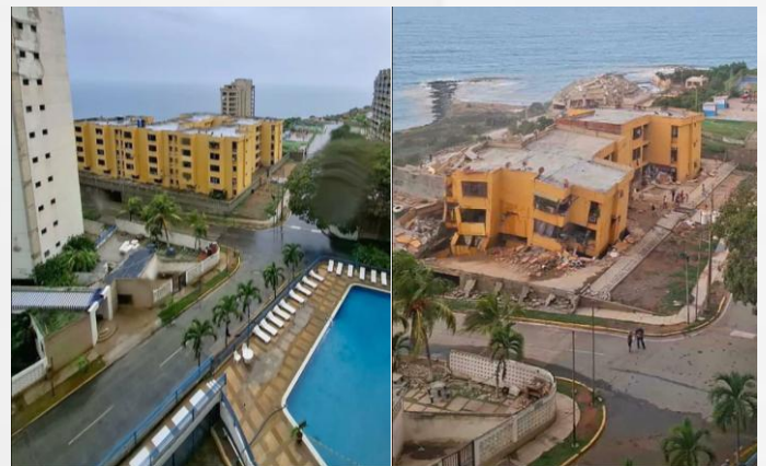
Antes y después de edificio en sector Playa Grande, La Guaira / Before and after of a building in Playa Grande sector, La Guaira Fuente/Source: infobae.com/venezuela
