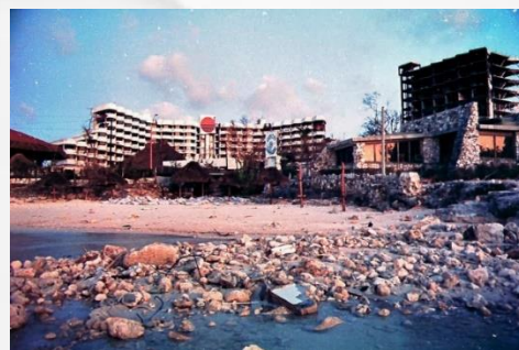
Figura 3. Hotel Sol Caribe de la zona hotelera de Cozumel después del paso del huracán Gilberto en 1988 ( https://aclarando.wordpress.com/tag/huracan-gilberto/ )
