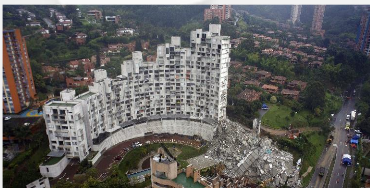
Figura 6. Colapso de la etapa 6, edificio Space. Fuente: http://primiciadiario.com
