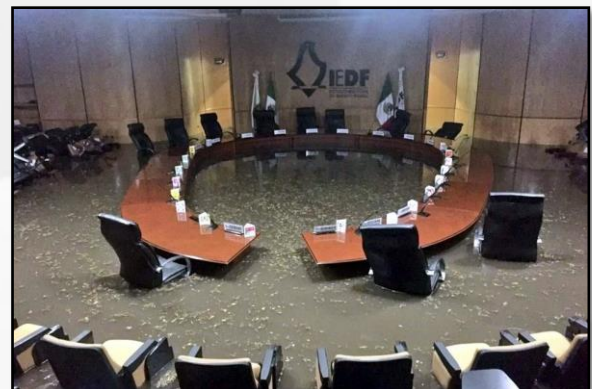
Inundación en la Sala del Consejo General del IEDF. Foto: vía Twitter / @Iberomed
