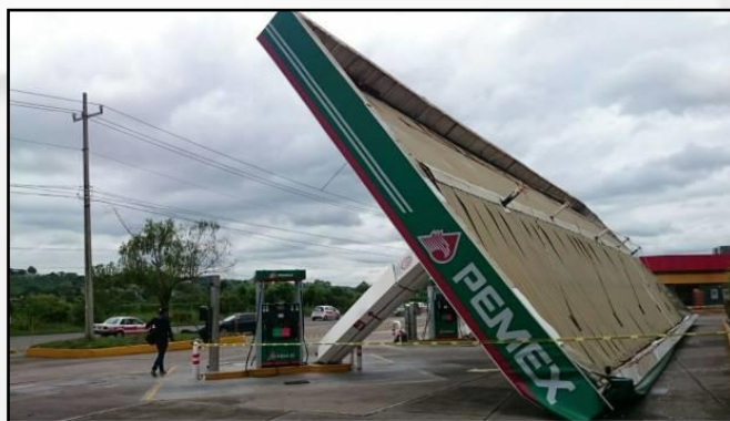
Volteo de estructuras metálicas en Veracruz. Fuente: Cuartoscuro
