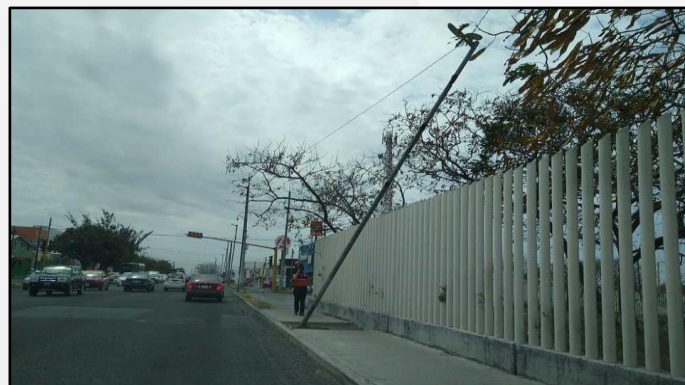
Figura 10. Colapso parcial de postes de luz debido a los fuertes vientos que se presentaron.
