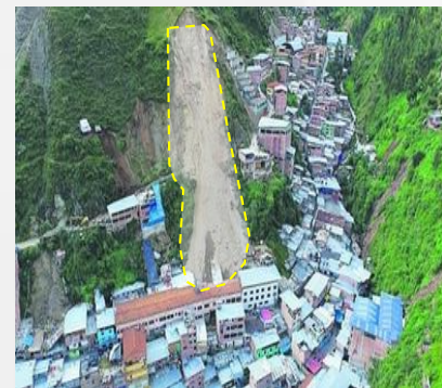
Figura 4 Deslizamiento en el sitio
