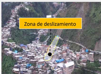
Figura 2 Zona de deslizamiento
