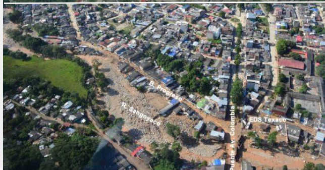
Fotos aéreas de las zonas afectadas por el deslizamiento (antes y después. Fuente: miputumayo.com.co/
