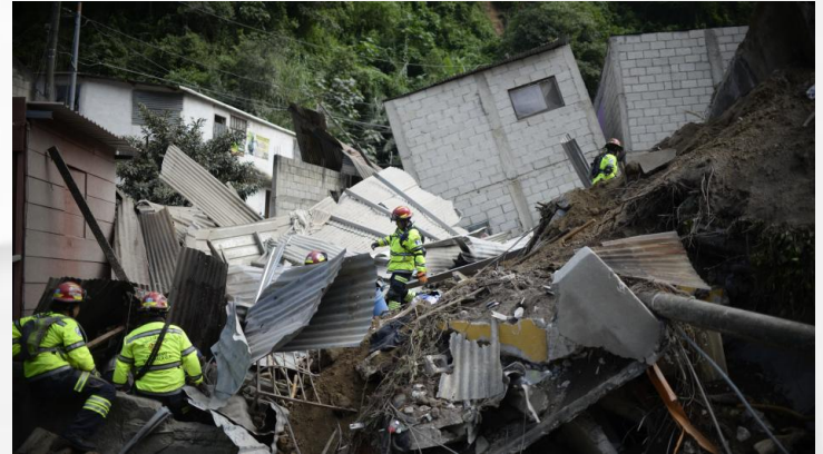
Figura 2. Daños en viviendas por deslizamiento Fuente: cnespanol.cnn.com
