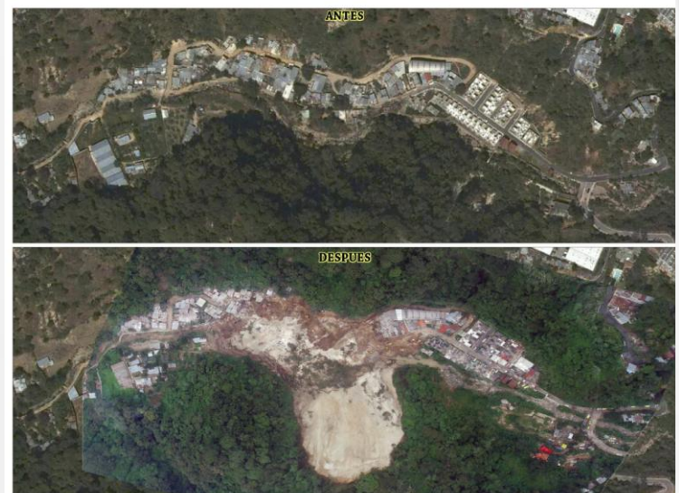
Figura 3. Zona de desastre antes y después del deslizamiento. Fuente: CONRED
