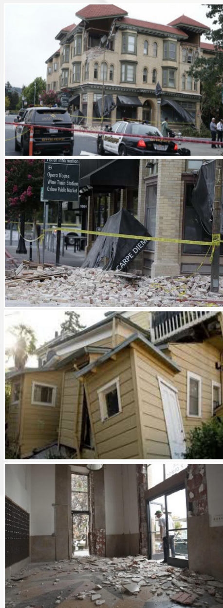
Figura 4. Daños estructurales en diversos edificios públicos en el centro de Napa.
