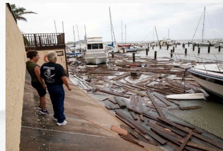
Daños en Puerto Costa del Sol, en Corpus Christi. Fuentes Courtney Sacco/Caller-Times via REUTERS
