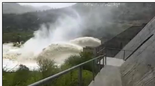
Descarga de la presa Buena Mujer, Baja California Sur (1 de septiembre) / Buena Mujer dam discharge, Baja California Sur (September 1 st )
