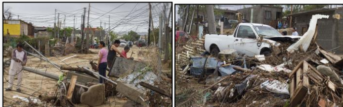
Daños en vías residenciales / Damage in residential neighborhoods Fuente/Source: http://www.eluniversal.com.mx/ ; http://cnnespanol.cnn.com
