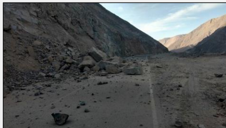
Deslizamiento de tierra en carretera entre Otapara y La Joya Landslides in highway between Otapara and La Joya Fuente / Source: TV Perú - Santiago Neyra
