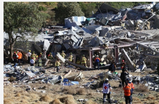
Figura 2. Vista de la zona afectada
