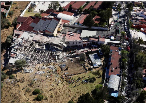
Figura 1. Vista aérea del Hospital Materno Infantil de Cuajimalpa, antes y después de la explosión.
